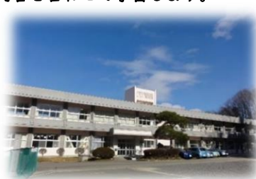
南側から見た校舎
